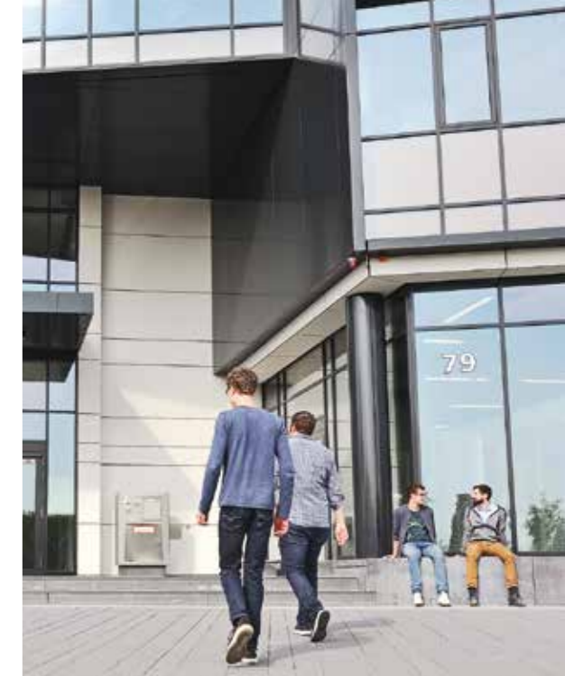
1 Industry Building DPP (re.) und Research Center DPP (li.) im Cluster Photonik, © Forschungscampus DPP, Aachen. 2 Eingangsbereich des Industry Building DPP im Cluster Photonik, © Forschungscampus DPP, Aachen.
